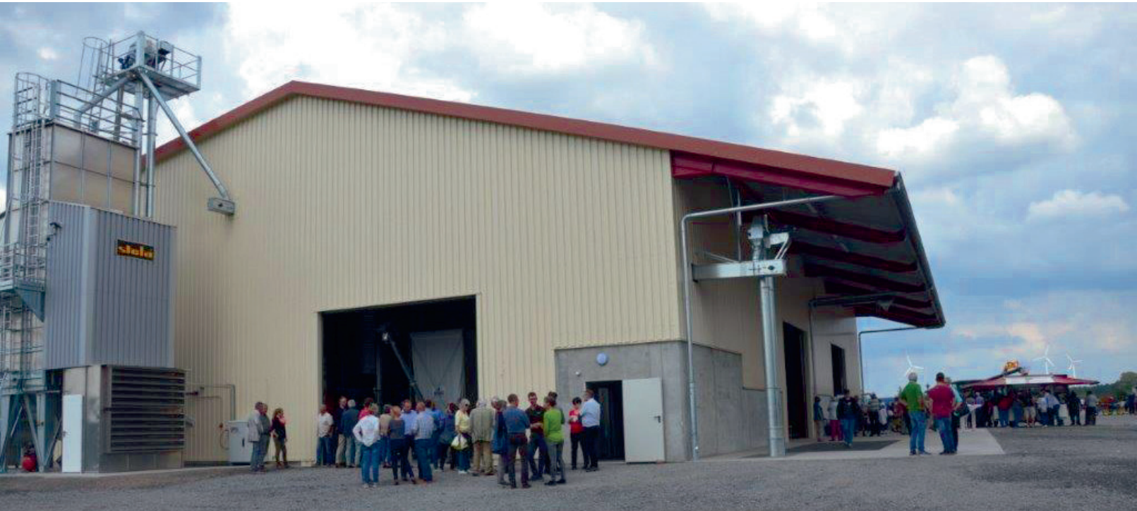
Die neue Lagerhalle konnte im Juli 2019 in Betrieb genommen werden.
