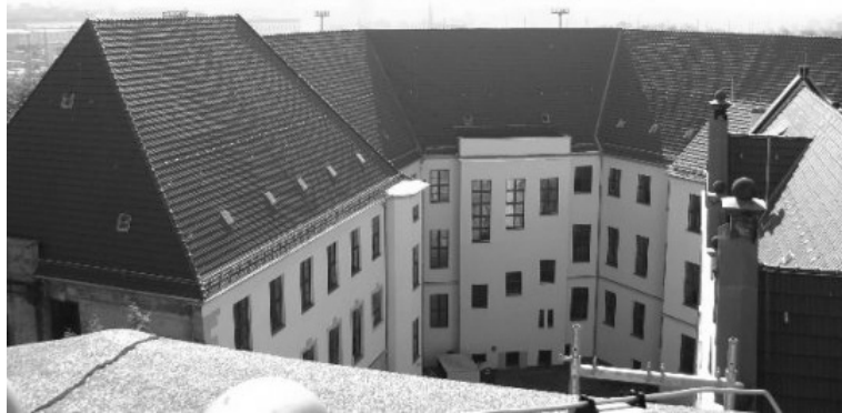
Dienstgebäude Olvenstedter Straße in Magdeburg
