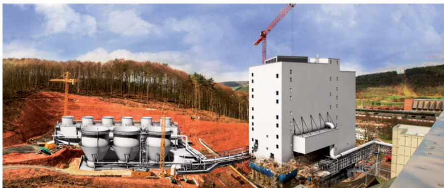
Kainit-Kristallisations-Flotations-Anlage (KKF-Anlage), K + S 2016
