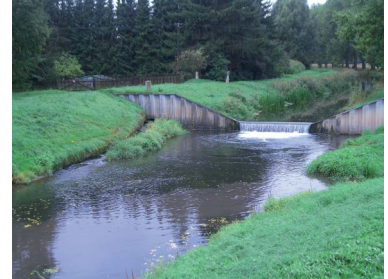
Wehranlage an der Ilme bei Einbeck
