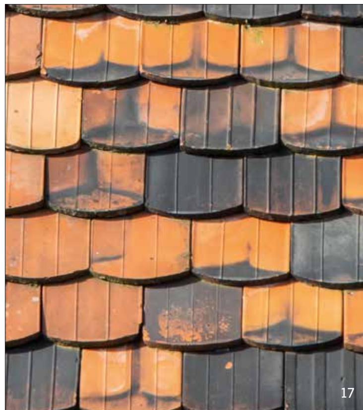
Abb. 16–17 Quedlinburg, Neueindeckung mit Biberschwanzziegeln, teilweise in Sekundärverwendung
