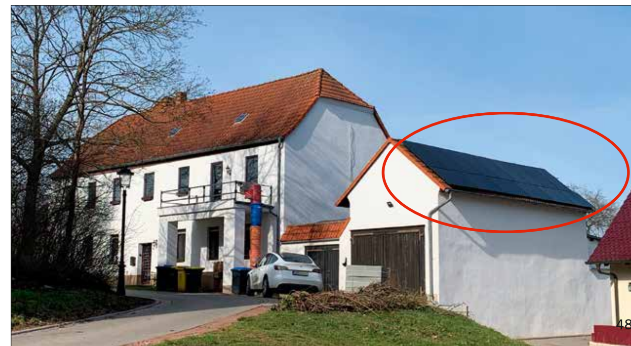
Abb. 48 Wettin-Löbejün, OT Wettin, Wohnhaus, Montage einer dachflächenparallelen PV-Anlage auf einem Nebengebäude im Denkmalbereich, die darüber hinaus nicht über die Dachflächenbegrenzungen (First, Ortgang) hinausragt
