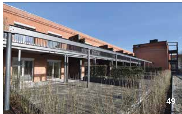
Abb. 49–50 Burg, hinter einer baulich bedingten Sichtbarriere (Attika) montierte, aus dem öffentlichen Raum nicht einsehbare PV-Module
