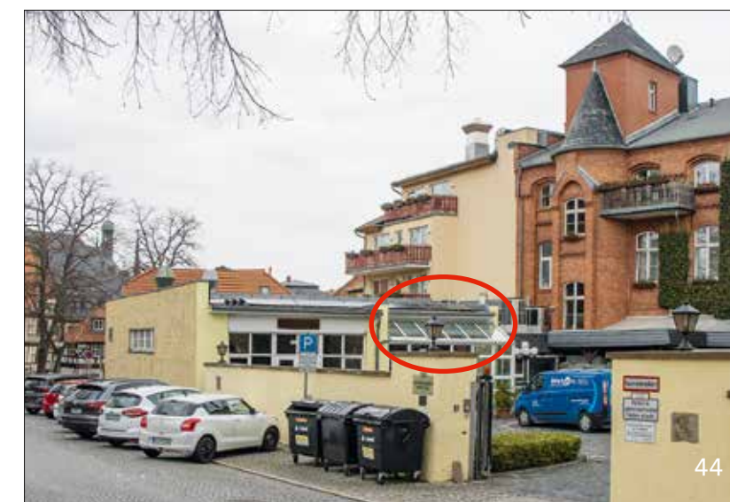
Abb. 44 Wernigerode, auf einem rückwärtig gelegenen Nebengebäude jüngeren Datums montierte PV-Anlage, aus dem öffentlichen Raum kaum wahrnehmbar
