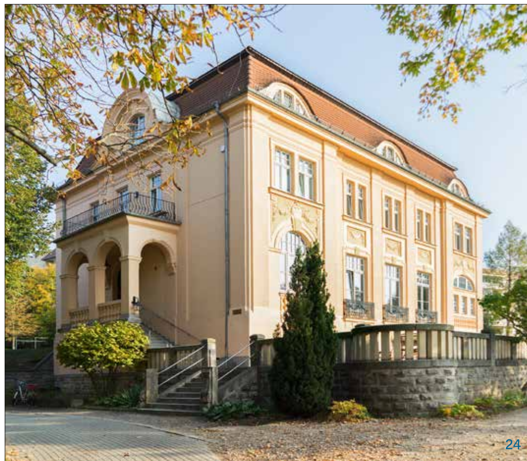
Abb. 23 Dessau, Verwaltungsgebäude, repräsentative Klinkerfassade
