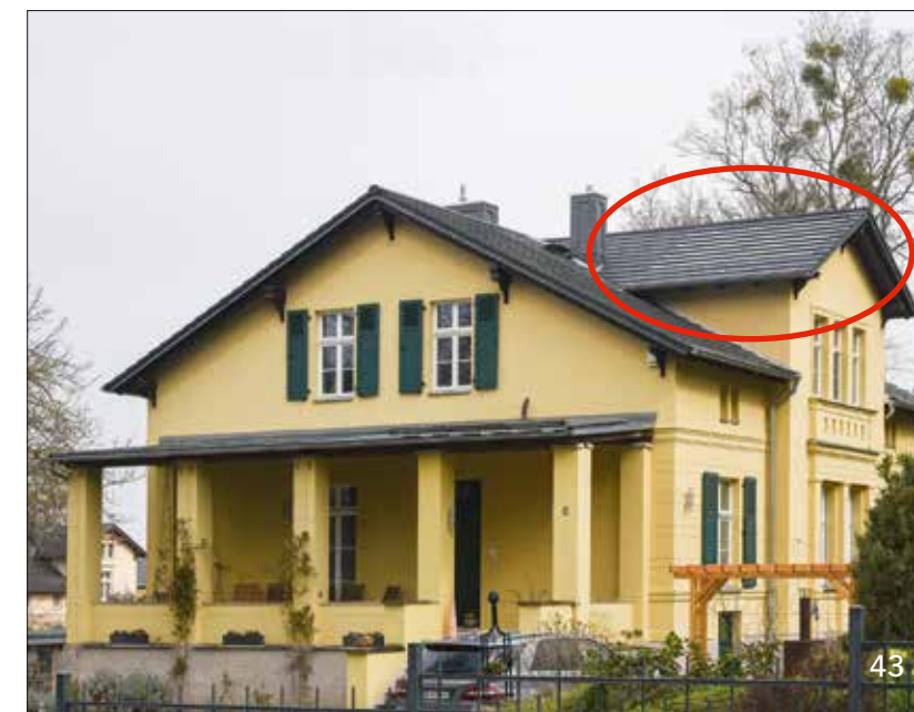
Abb. 43 Naumburg, Villa, farblich angepasste, kleinformige Indach-Solarmodule
