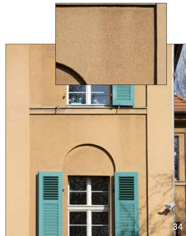
Abb. 34 Halle (S.), Villa mit bauzeitlichem Putz, dieser durchgefärbt und mit grobem Glimmerzuschlag
