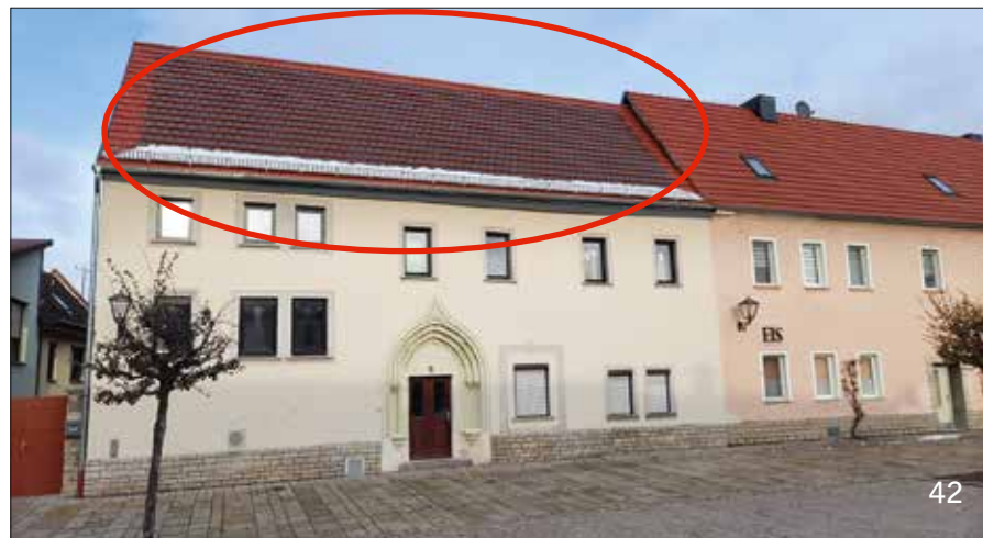
Abb. 45 Nebra, Wohnhaus, mit kleinformatischen und farblich an den Bestand angeglichenen Solardach ziegeln
