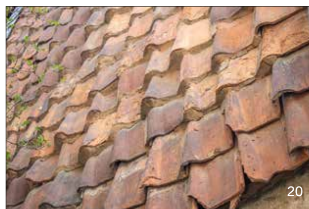
Abb. 18 Blankenburg (Harz), Dachdeckung mit Linkskrempziegeln Abb. 19–20 Blankenburg (Harz), Giebelbehang mit vermörtelten Linkskrempziegeln
