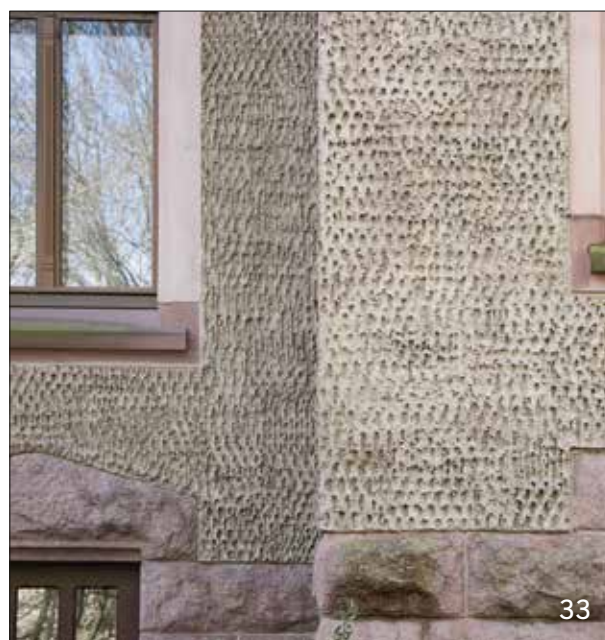
Abb. 33 Halle (S.), Wohnhaus mit erneuertem Stippputz
