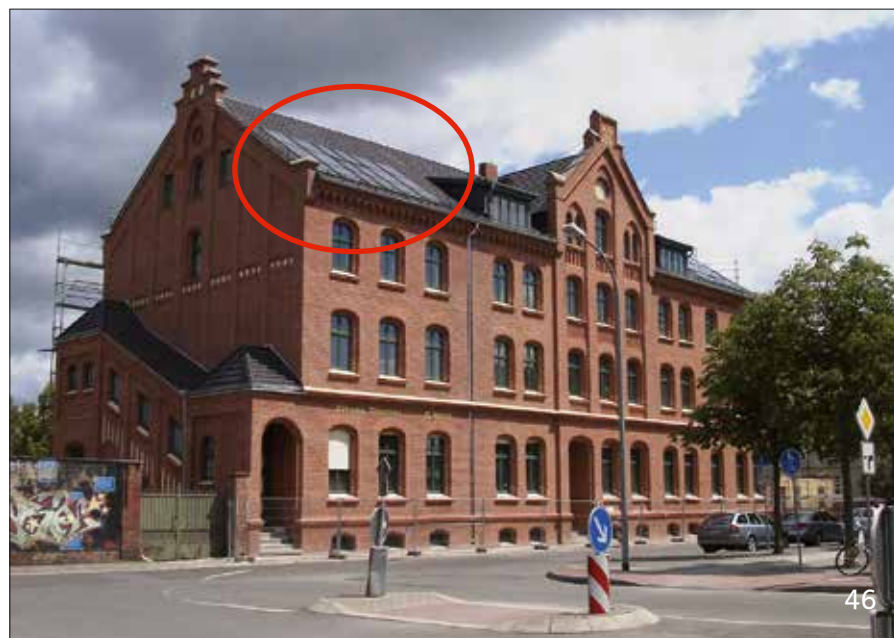
Abb. 46 Stendal, Herberge, mit in die Dachhaut integrierter Solarthermieanlage
