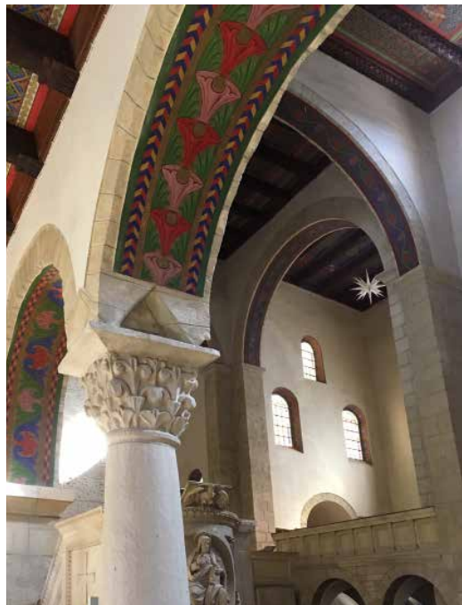
aufwendige Deckenmalereien- nach der Sanierung
