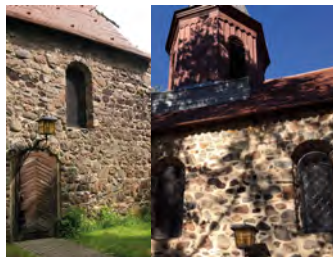
Mauerwerk vor (links) und nach der Sanierung
