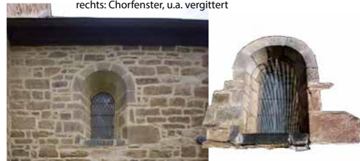
links: südliches Chorfenster nach der Sanierung rechts: Chorfenster, u.a. vergittert
